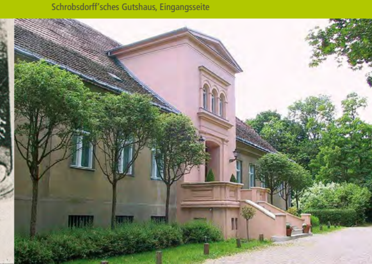
Schrobsdorff'sches Gutshaus, Eingangsseite
